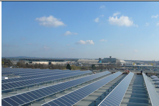
Solarstromanlage auf dem Dach des Cargo Service Centers am Flughafen Köln/Bonn.
