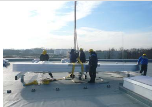
In nur sechs Wochen gelang die Installation aller Anlagekomponenten.
