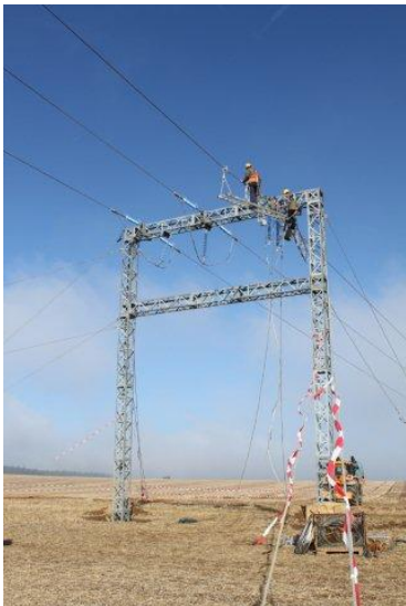
Arbeiten an der Hochspannungsleitung (Versetzen eines Masts); Blick durch die Modulreihen (rechts)
