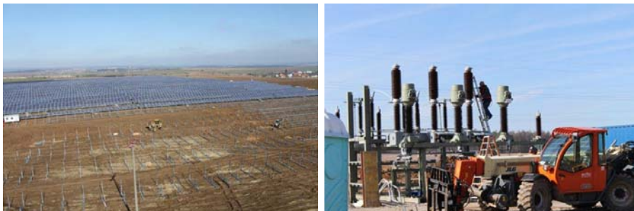
Blick über den Park, Bauarbeiten am Umspannwerk
