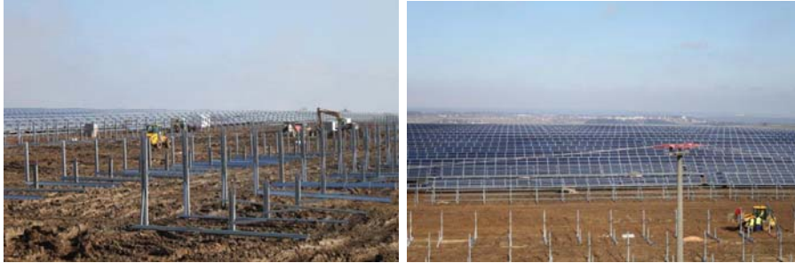
Gerammte Pfähle, Gestellmontage, Blick über den Park
