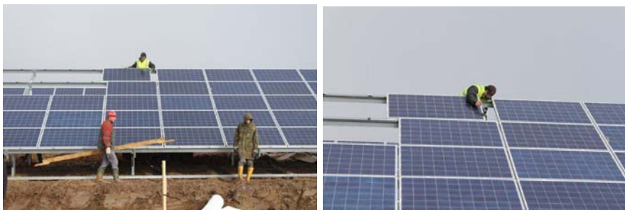
Montage der Module
