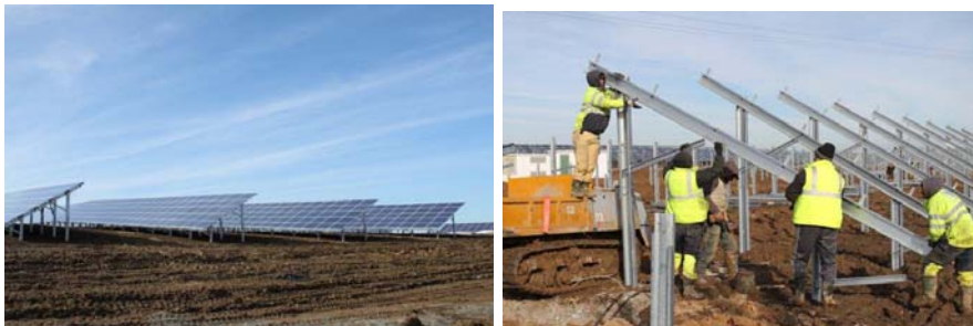
Fertig montierte Modulreihen, Montage der Modultische
