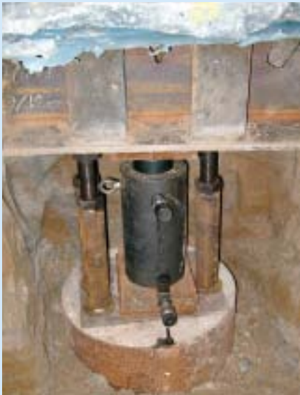
Foto/Photo: ERKA Pfahl GmbH
