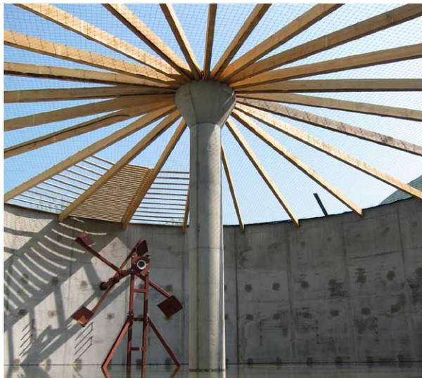
So sah es im Innern des Nachgärers aus, bevor die Folie an den Balken befestigt wurde, die das Gebäude nun abschließt und einen Austritt des Gases verhindert. Das Großflügelrührwerk sorgt für die Zirkulation des Substrats.
