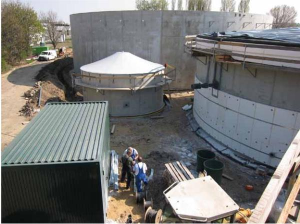
Blick vom Fermenter auf die mittlerweile abgeschlossenen Bauarbeiten. Links im Bild befindet sich der Technikcontainer, rechts der Nachgärer, in der Mitte die Vorgrube. Im Gärsubstratlager (großes Gebäude im Hintergrund) wird das bereits komplett vergorene Material gesammelt, bevor es als hochwertiger Dünger auf die Felder kommt.
