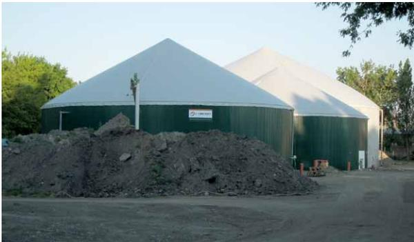
Der vordere Fermenter bietet 2.500 Kubikmeter Platz. Hier verbleibt die Gärsubstanz durchschnittlich 70 Tage, bevor sie in den etwas kleineren zweiten Fermenter kommt, der auch als Nachgärer bezeichnet wird. Nach weiteren 60 Tagen ist das Substrat vollständig vergoren und landet im großen Lager (Hintergrund).
