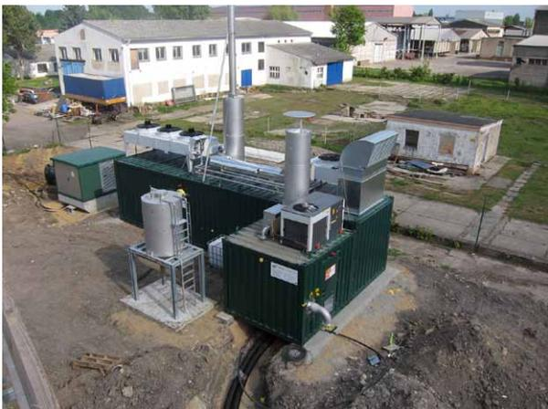
Das große Blockheizkraftwerk am Standort der Biogasanlage verfügt über 600 Kilowatt elektrische Leistung. Vorne rechts ist der Gastransportcontainer zu sehen, links vorne der Aktivkohlefilter. Der Trafo ganz links transformiert den Strom von Nieder- auf Mittelspannung, bevor er dann in die 20 kV-Leitung eingespeist werden kann.
