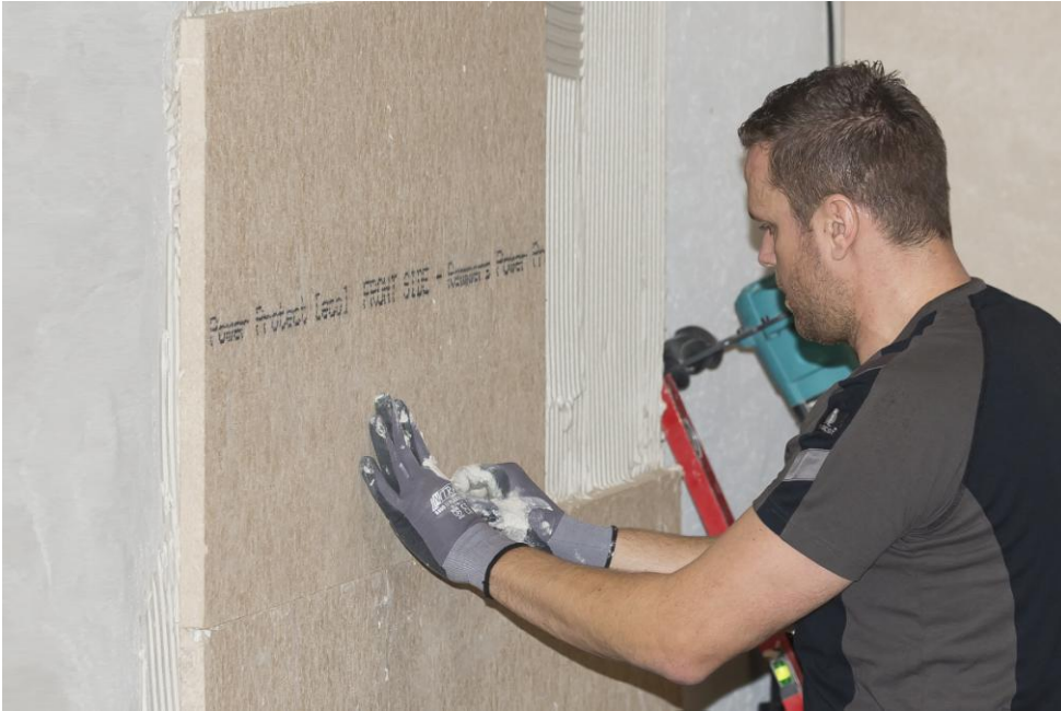
Anbringen der Schimmelsanierplatte Power Protect [eco] von Remmers.
