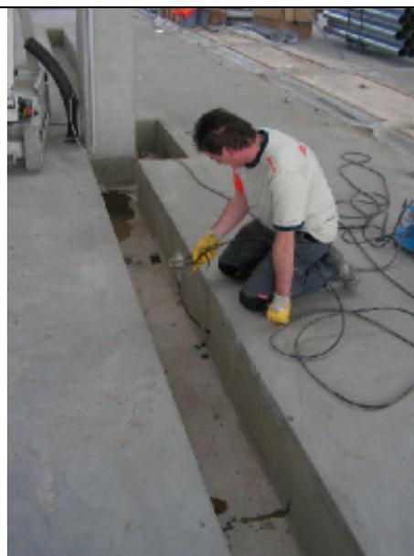
Ein Abdichtungstechniker von Drytech während dem Injektionsvorgang bei einem der Bodenkanäle für die Ölver- und Altöleentsorgung.
