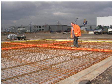
Drytech-Monteure befestigten DRYset-Injektionsprofile als Sollrisselemente Boden/Boden zwischen der Ober- und Unterbewehrung einer Abstellfläche für verunfallte LKW.
