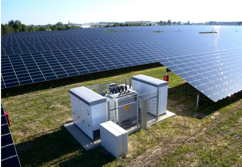
Bildunterschrift: Wechselrichterstation in einem netzstabilisierenden Freiflächen-Solarkraftwerk.
