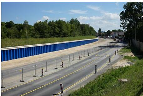
Die Beschichtung der Spundwand ist an der westlichen Ausfahrt der Tunnelröhre fertiggestellt. Alle Arbeiten finden unter laufendem Verkehr statt.
