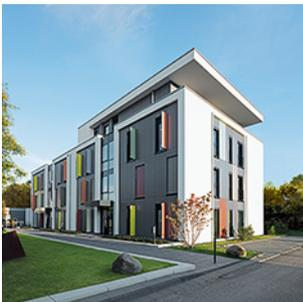
Weißer Putzflächen, graue Fassadenplatten und farbige Sichtschutz-Elemente vor den Energiesparfenstern Schüco Corona SI 82 tragen zu einer lebendigen, individuellen Fassadengestaltung bei.
