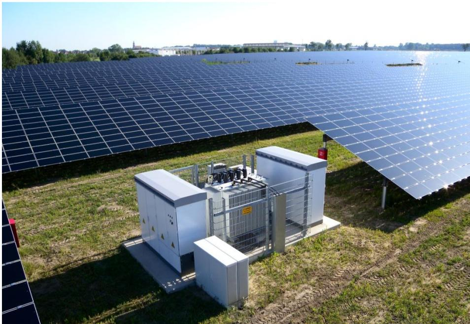
**Bildunterschrift:** Wechselrichterstation in einem netzstabilisierenden Freiflächen- Solarkraftwerk.
