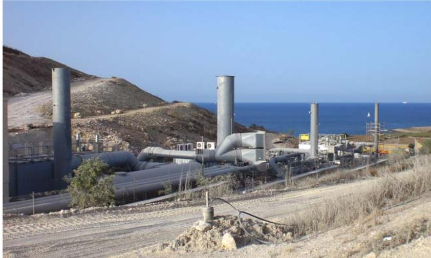
In einer VocsiBox<sup>®</sup> wird das methan- und schadstoffhaltige Gas, das im Inneren der stillgelegten Deponie entsteht, bei Temperaturen von ca. 1.000 °C oxidiert und damit unschädlich gemacht. Die eingesetzte Wärmeenergie wird regeneriert (RTO = Regenerativ-thermische Oxidation).
