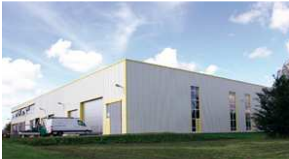
Außenansicht der neuen psb Fertigungshalle (Photo: psb intralogistics GmbH)
