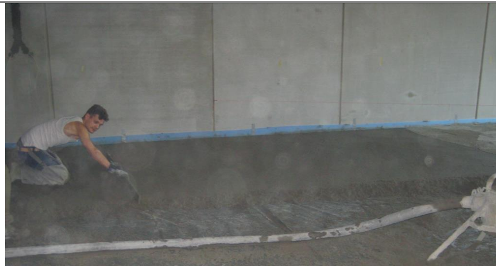
Zunächst brachten die Fachleute der Firma Laux & Söhne den Estrich ein, bevor direkt im Anschluss im Rüttelverfahren die Fliesen verlegt wurden.
