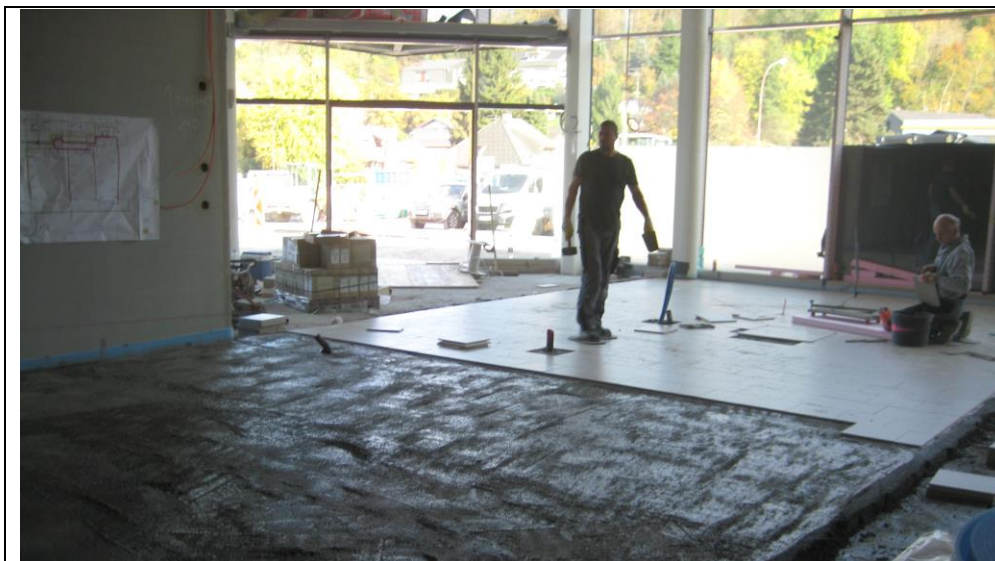
Rüttelboden, ein Einsatzbereich für erdfuchte Estriche und den EstrichBoy EC 350.
