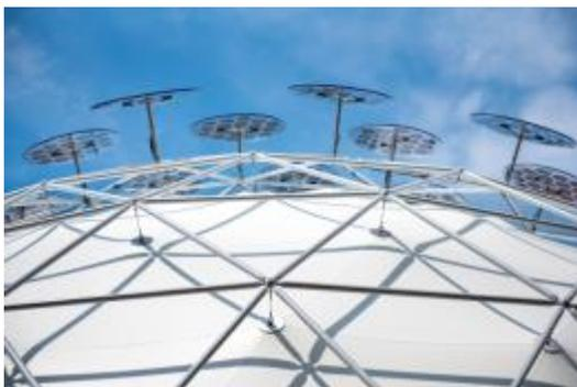
Foto 1: Nahaufnahme der OPV Solar-Schirme auf der Tragstruktur des Klima-Pavillons
