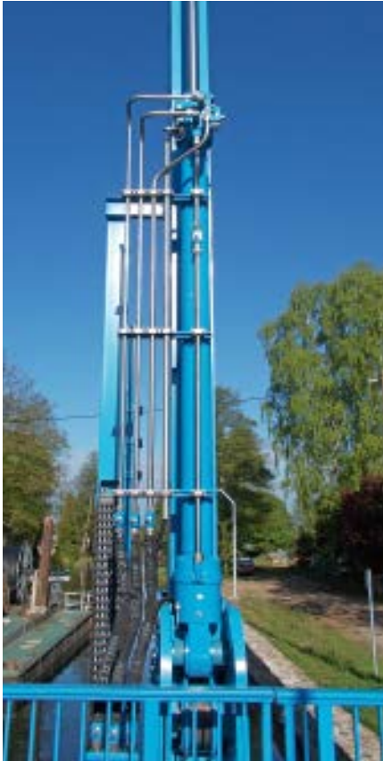
» Die Brücke wird innerhalb von 120 Sekunden um 2,7 Meter angehoben – die Kraft dafür kommt von zwei Motoreinheiten. » The bridge is raised 2.7 metres in just 120 seconds – with the necessary power supplied by two motor units.
