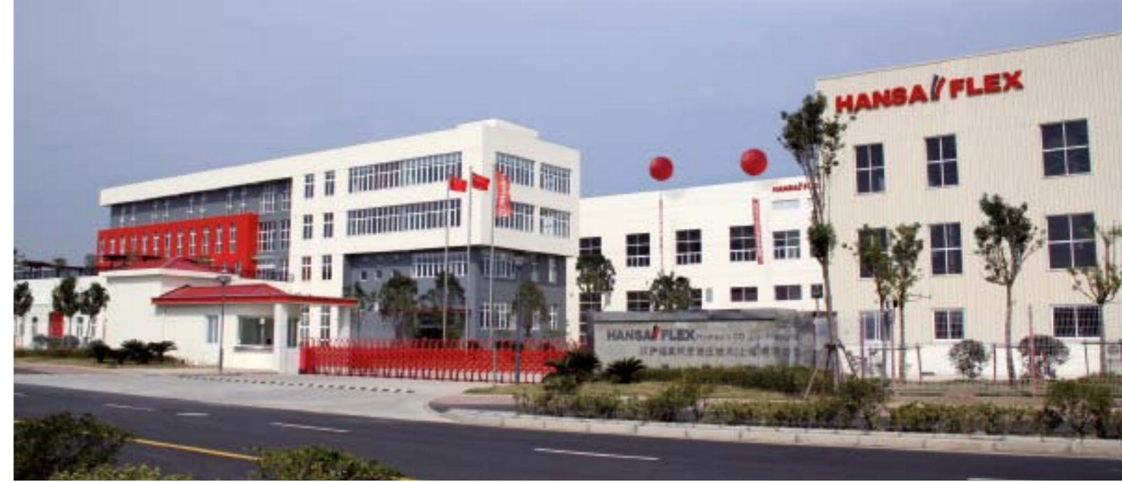
» 2009 eröffneten wir die neu gebaute Zentrale für den asiatischen Markt in Shanghai/China. » In 2009 we opened our newly built headquarters for the Asian market in Shanghai/China.
