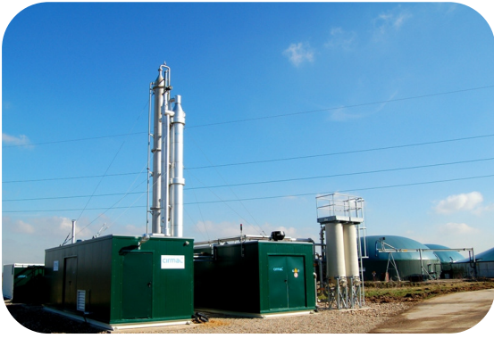
Bild 2: Aufbereitungscontainer inkl. Biogasanlage
