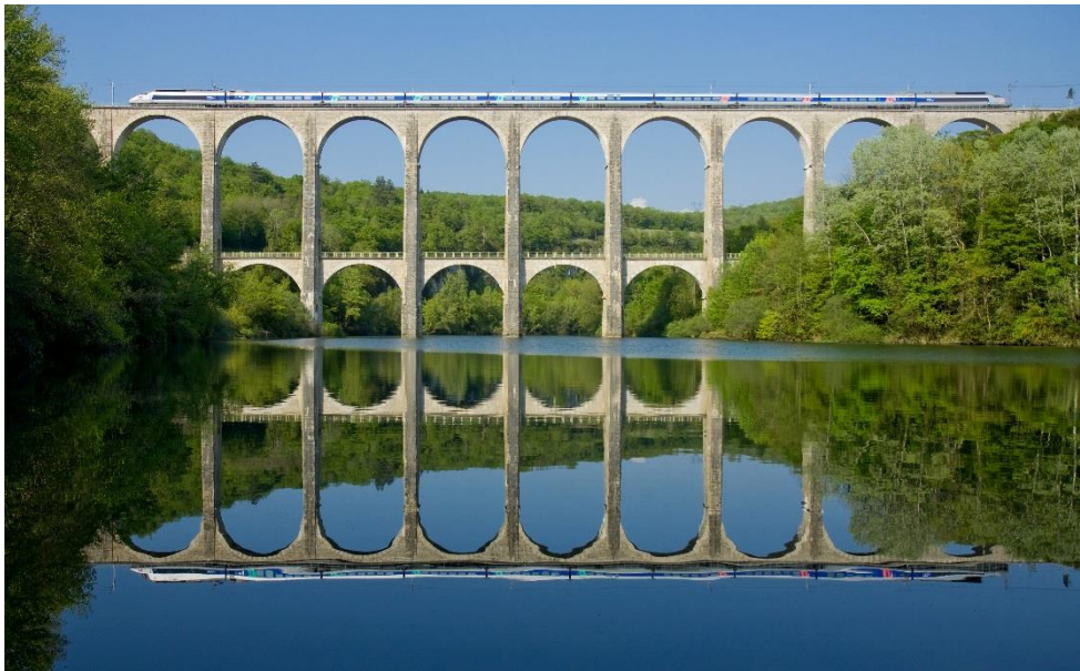
TGV auf dem Viadukt von Cize-Bolozon, ©davidgubler, fotolia
