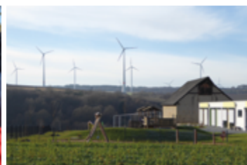
Neue Kita in Berglicht dank Einnahmen aus der Windenergie
