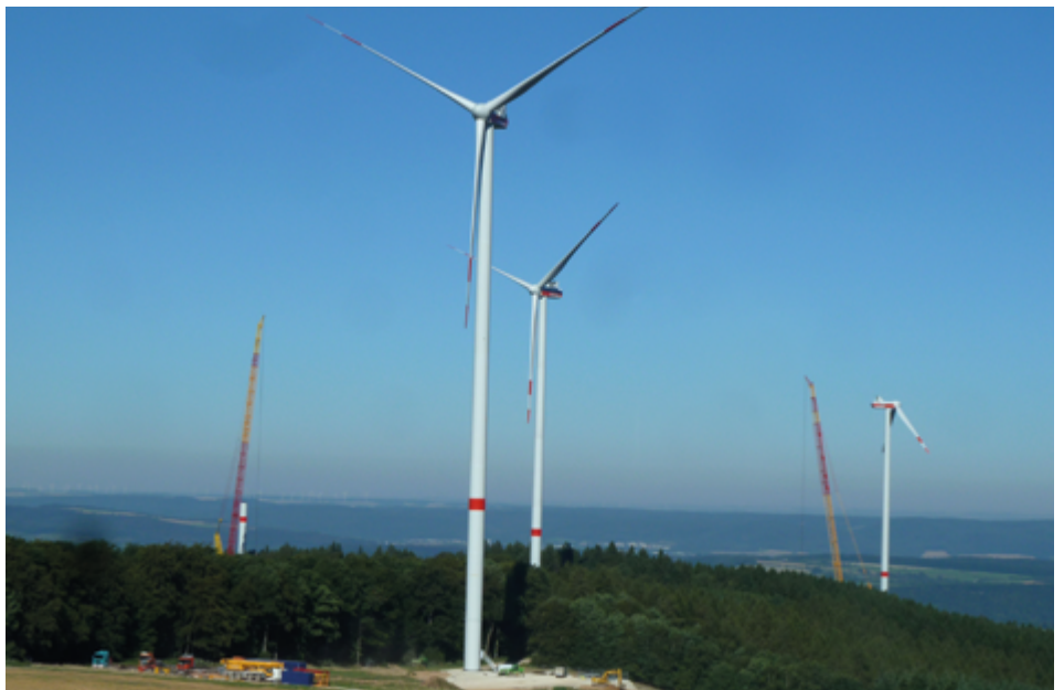
Die Windkraftanlagen in verschiedenen Bauphasen.
