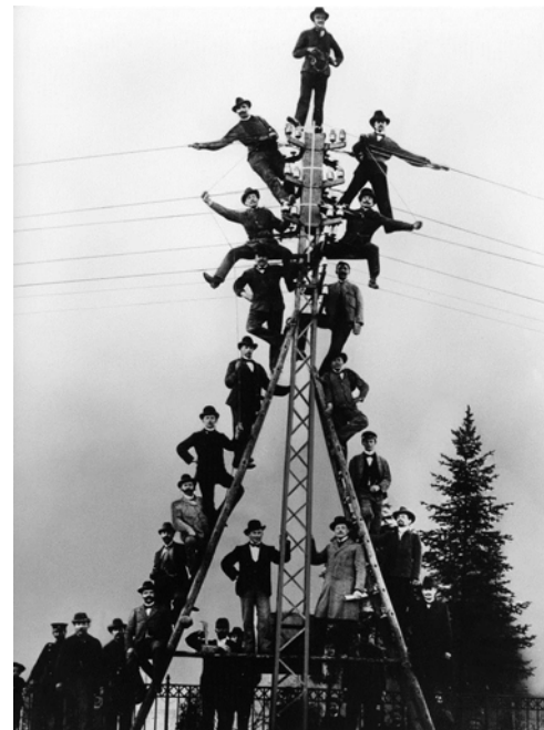
Richtfest einer Niederspannungsleitung
