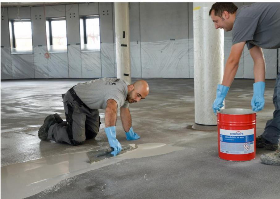
Auftrag von Epoxy Primer PF New als pigmentierte Grundierung und Basisschicht.
