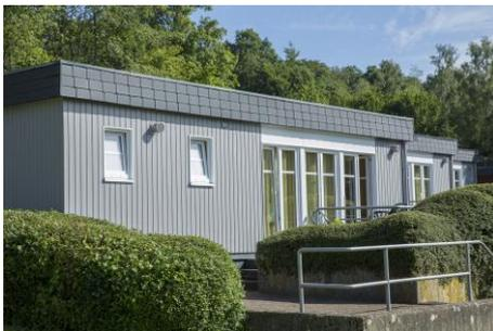
Im Zuge der Sanierung 2013 wurden die Fassaden der Ferienhäuser erneuert. Sie waren zum Teil so stark verwittert, dass das Holz komplett ausgetauscht werden musste.
