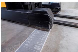
*Das neue Fugensystem MC-Floor Connect der MC-Bauchemie kann schnell und kantenfrei verlegt werden, ist hoch beständig gegen mechanische Beanspruchungen z. B. durch Staplerverkehr und sorgt für ein erschütterungsfreies und geräuscharmes Überfahren von Fugen*
