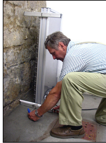
Bild: Wandtrockner im Einsatz
