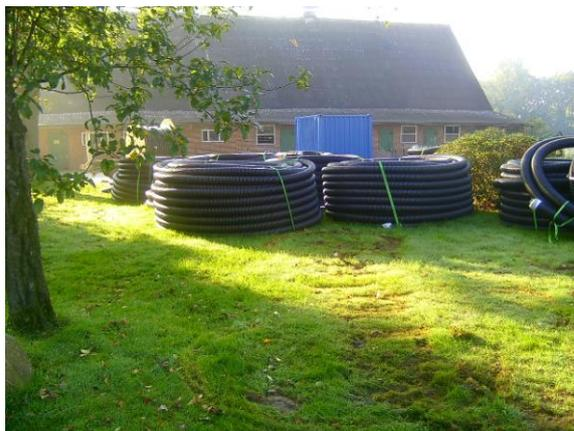
Die zukünftige Wärmeversorgung der Malstedter Haushalte wird durch die Erde über das vorisolierte, flexible Rohrsystem Flexalen™ erfolgen.
