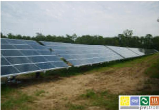
2010 entstand in Geroldsgrün ein neuer Solarpark auf einer Fläche von 1,3 Hektar. Die Freilandanlage verfügt über eine Nennleistung von 585 kWp. Mehr als 600 MWh sollen damit im Jahr produziert werden.
