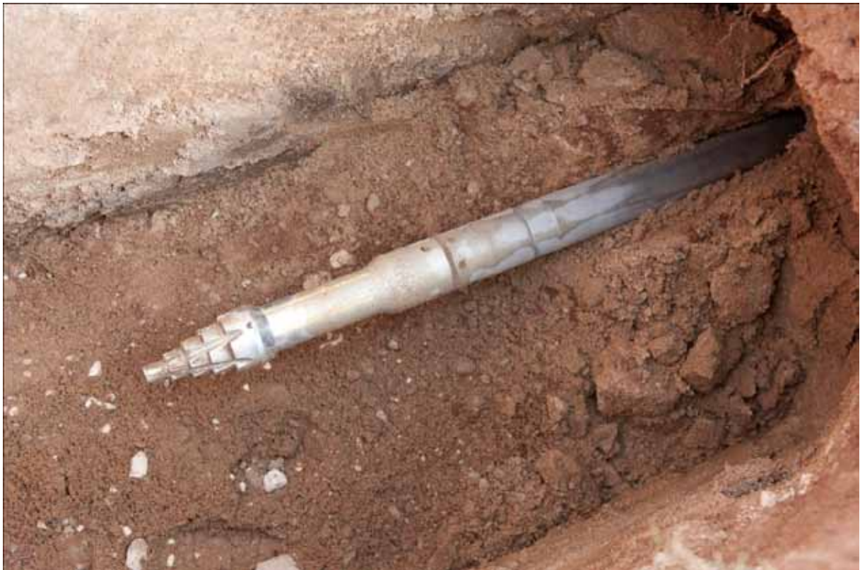
Abb. 3: Ankunft der TERRA HAMMER Erdrakete in der vorbereiteten Zielgrube.
