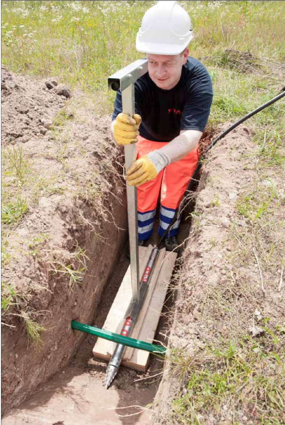
Abb.1: TERRA HAMMER Erdrakete in der Startgrube. Darüber RAUSPEED Mikrokabelrohre mit grünem Außenmantel.
