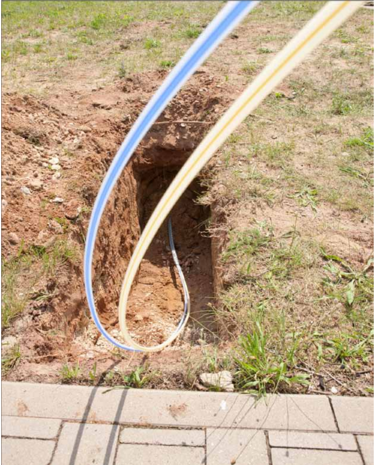
Abb. 4: Einziehen der RAUSPEED Mikrokabelrohre für den schnellen FTTx-Hausanschluss während des Rücklaufs der Erdrakete.
