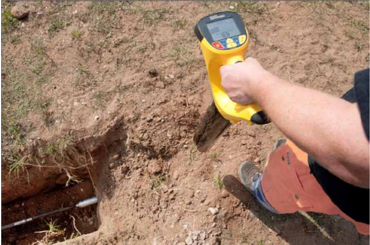
Abb. 2: Zentimetergenaue Ortung der TERRA HAMMER Erdrakete während der Bohrung.
