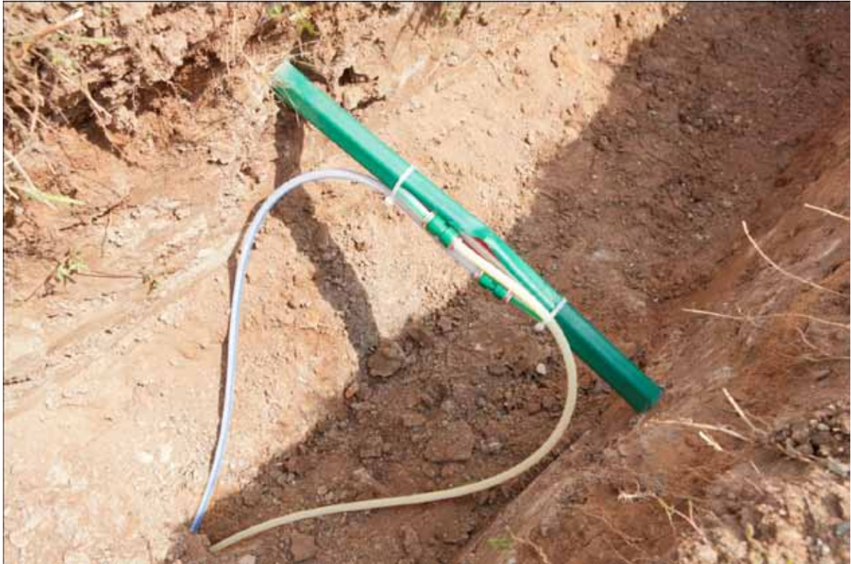
Abb. 5: Fachgerechter Anschluss der abzweigenden RAUSPEED Mikrokabelrohre für den FTTx-Hausanschluss an die Hauptleitung.
