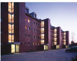
Düsseldorfer Klinkeroptik der 60er Jahre: Die Gebäude wirken seit Abschluss der Fassadenmodernisierung wie neu gebaut. Die Fassaden wurden mit Capatect-Dämmplatten auf das aktuell geforderte EnEV-Niveau gebracht und mit Spaltverblender bekleidet.
