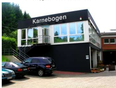
Frontansicht mit Bürotrakt
