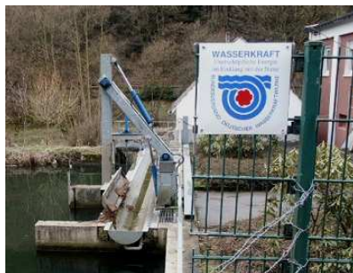
Wehr mit Rechenreiniger
