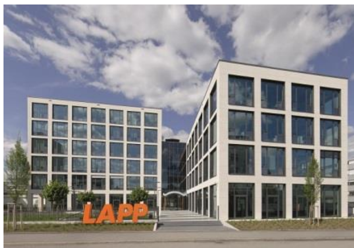
Bild 2: Am Firmenhauptsitz in Stuttgart-Vaihingen hat die Lapp Gruppe ein Gebäude errichtet, das mit seinem Bürokonzzept Maßstäbe setzt
