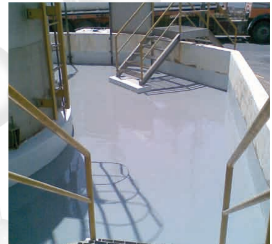
6) Großflächige Auffangeinrichtung für Schwefelsäurefabrik
