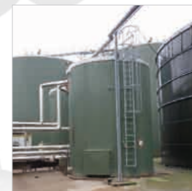
5) Biogas-Fermenter, Innenbeschichtung Betonboden gegen SRB-Bakterien
