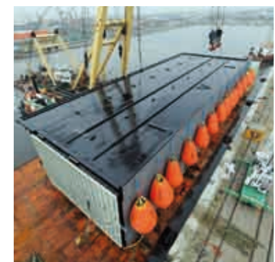
1) Erdöltanks und Separatoren auf Offshore Plattform, Innen- und Außenbeschichtung 2) Schleusentor, Außenbeschichtung
