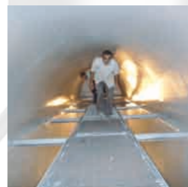
6) Separationsbehälter für Abwassernetz
