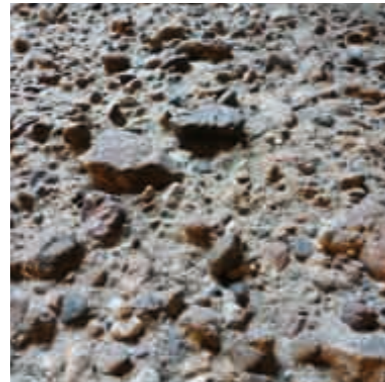
2) Betonauswaschungen
