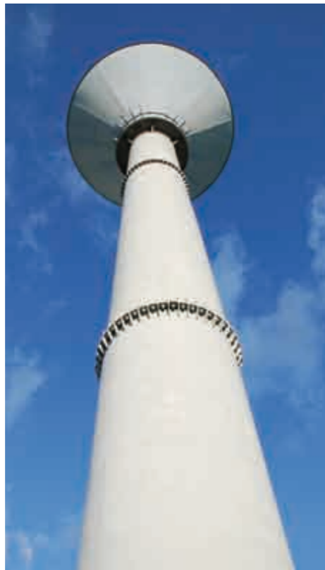
1) Wasserturm „Aquaglobus“, Innenbeschichtung
