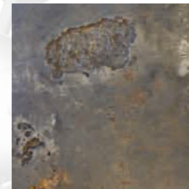
2) Fortgeschrittene anaerobe Korrosion durch SRB im Bodenbereich eines Tanks
