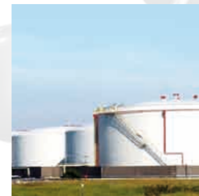
4) Sicherheitsboden von Doppelmanteltank für chemische Restprodukte, Innenbeschichtung 5) Großflächige Auffangeinrichtung für Phosphorsäure tanks, Außenbeschichtung
