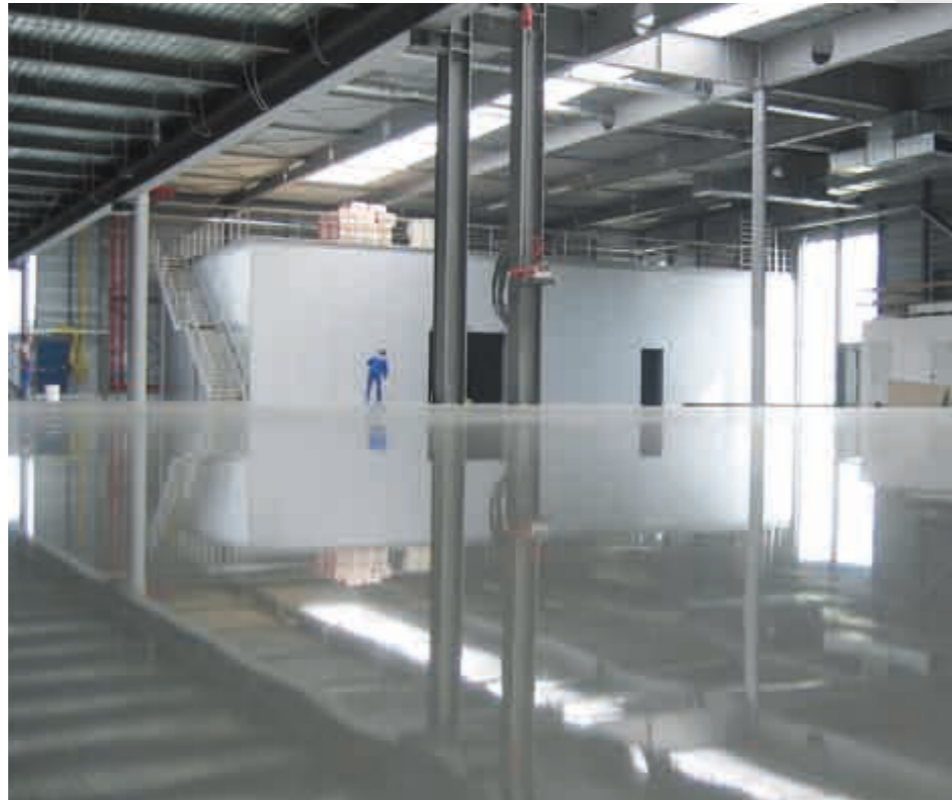
5) Lagerhalle, antibakterielle und physiologisch unbedenkliche Bodenbeschichtung
