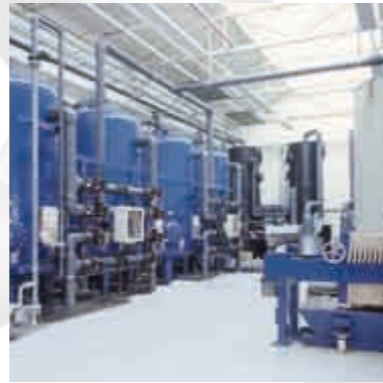
2) Sandfilter für Trinkwasser, Innen- und Außenbeschichtung
