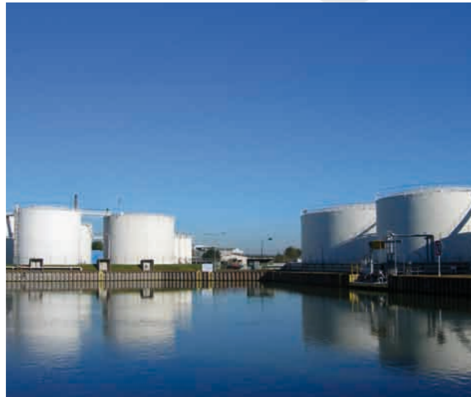
1) Lagertanks für diverse Säuren, Innenbeschichtung
