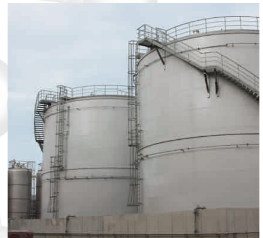
6) Doppelmanteltanks für Ethanol, Innenbeschichtung und Beton-Auffangwanne, Außenbeschichtung
