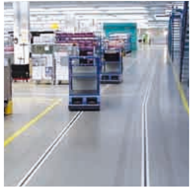
1) Produktionshalle, Pharmazeutische Industrie, chemisch beständige Bodenbeschichtung
