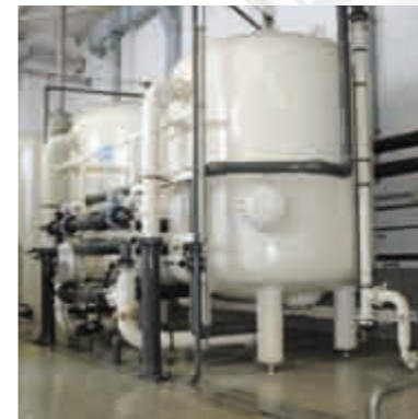
1) Filteranlage für Trinkwasser, Innen- und Außenbeschichtung
