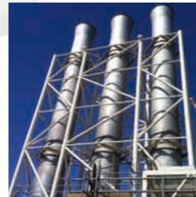
1) Abgasaustrittsrohre in Chemikalienfabrik, Innenbeschichtung
