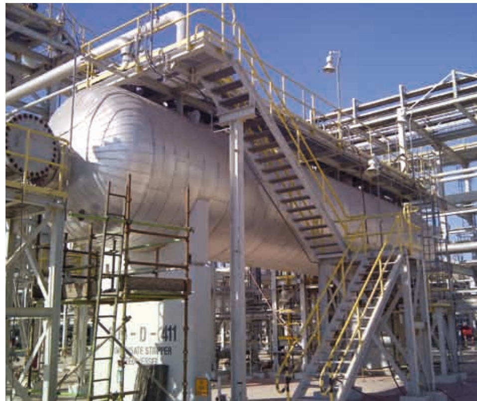
1) Kondensat-Abscheider, Gas-Raffinerie, Innenbeschichtung
