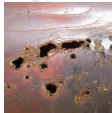
1) Lochfraß, ausgelöst durch anaerobe Biokorrosion
