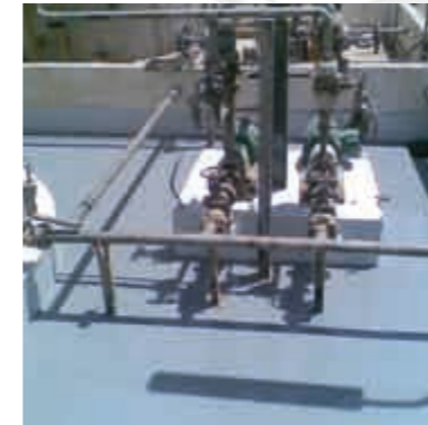
1) Auffangwanne für Hydraulikflüssigkeiten
