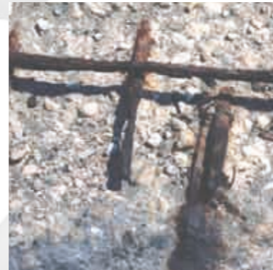
3) Korrosion der Stahlbewehrung
