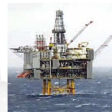
5) Erdöltanks und Separatoren auf Offshore Plattform, Innen- und Außenbeschichtung
