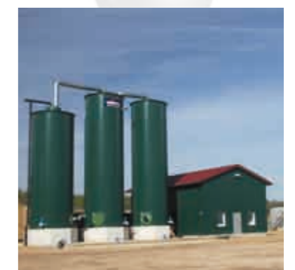
Foto: Energie-Anlagen Röring
