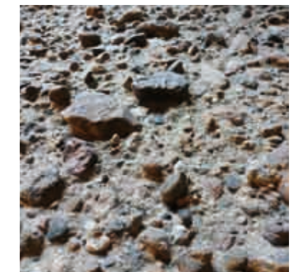
3) Betonauswaschungen durch chemischen Angriff des entstehenden Schwefelwasserstoffs
