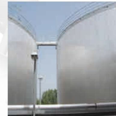
2) Lagertanks für heiße Fettsäuren, Innenbeschichtung
