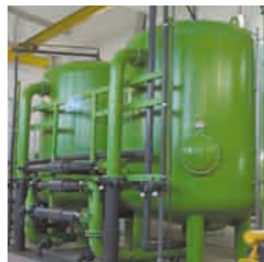
4) Filteranlagen für Trinkwasser, Innen- und Außenbeschichtung
