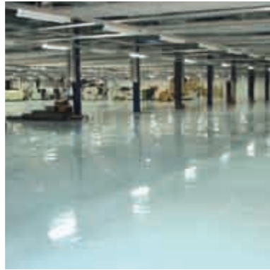
2) Produktionshalle, antistatische Bodenbeschichtung
