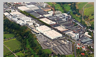
Luftaufnahme der Firmenzentrale in Heuchelheim bei Gießen
