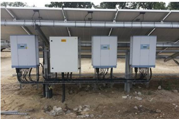
Für die Anlage wurden insgesamt 6.000 Solarmodule und 30 RPI M50A Solar-Wechselrichter von Delta mit 50 kW Leistung installiert.
