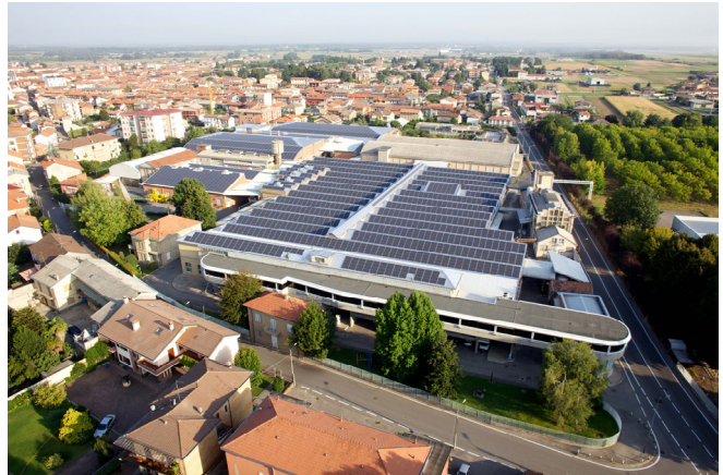
[Bildunterschrift] AS Solar eröffnet die 1MW Sanyo PV-Anlage auf den BOSSI-Produktionshallen (Datei: as_solar_bossi.jpg)
