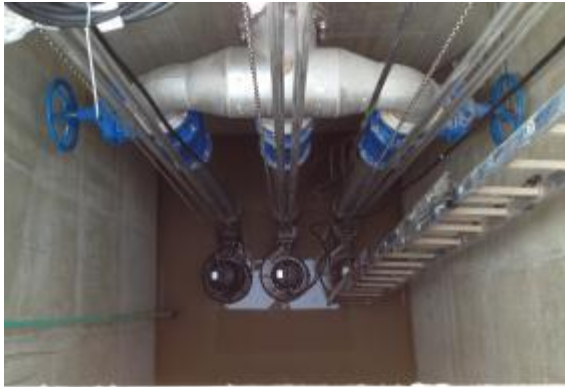
Bild 1: Regenwasserpumpwerk und Bild 2: Rückstauschleife zur Absicherung eines Logistikzentrums in Schwetzingen gemäß DIN 1986-100 (lt. DIN sind Flächen außerhalb von Gebäuden auch gegen Rückstau zu sichern).
