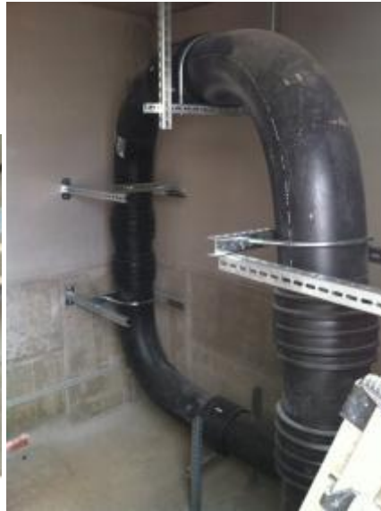
Bild 1: Regenwasserpumpwerk und Bild 2: Rückstauschleife zur Absicherung eines Logistikzentrums in Schwetzingen gemäß DIN 1986-100 (lt. DIN sind Flächen außerhalb von Gebäuden auch gegen Rückstau zu sichern).
