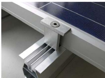
Die im Gewindekanal verschraubten Klemmplatten halten die Module.
