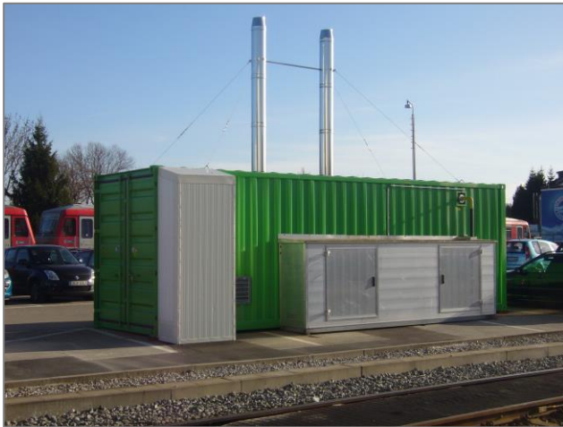
BU: Der Heizcontainer versorgt mit einer Leistung von 880 kW das Ausbesserungswerk der DB Regio AG in Kempten. (Datei: Heizcontainer_DB Regio-Kempten-Energie-Contracting.jpg)
