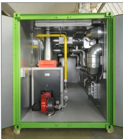
BU: Der 30-Fuß große Heizcontainer ist mit der neuesten Technik und Komponenten namhafter deutscher Hersteller bestückt. (Datei: Heizcontainer_DB Regio-innen.jpg)
