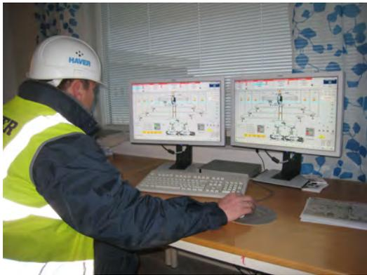
Eine Herausforderung, für die von HAVER & BOECKER gelieferte Automation lag darin, das Prozessleitsystem PCS7 dem Siloprozessen so anzupassen, dass klare und übersichtliche Verfahrensgruppen entstanden, die eine einfache Bedienung und schnelle Fehlererkennung ermöglichen (*Bild 4*). Durch den Datenaustausch zwischen Prozessleitsystem und dem Versandsystem, das von CEMENTA AB beigestellt wurde, werden die Tanklastwagen und Waggons entsprechend der Versandaufträge automatisch
