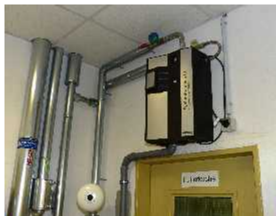
Für die kompakten Sicherheitstrennstationen von Dehoust findet sich in jedem Raum ein Montageplatz.
