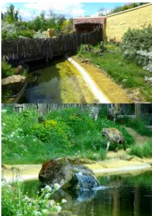
Bei den Tränken und Wasserbecken macht die Dehoust-Systemtrennung nach EN 1717 das Trinkwassernetz „Raubtiersicher“.
