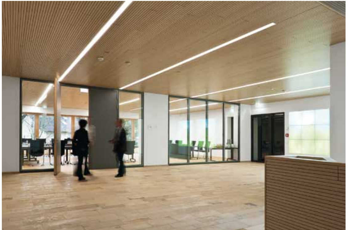
B4 | Die gänzlich neu gestalteten Sitzungssäle sind mit Ahornoptik verkleidet. Vom Gang bis in die Konferenzräume zieht sich die LED-Lichtlinie Slotlight einheitlich fort.
