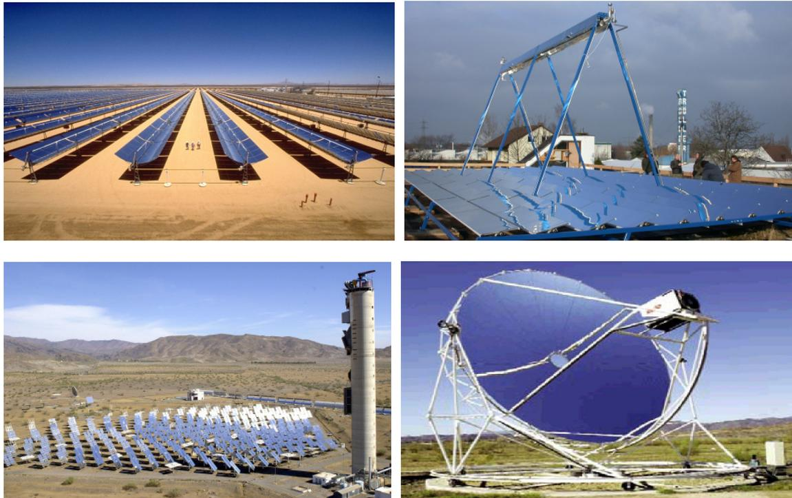
Abbildung 25: Wesentliche Technologielinien im Bereich solarthermischer Kraftwerke. 1a) Parabolrinnenkollektoren in einem Kraftwerk der SEGS-Reihe in Kramer Junction (Kalifornien); 1b) Fresnel-Kollektor (Feiburg); 1c) Turm-Versuchs-Kraftwerk (Plataforma Solar de Almeria in Spanien); 1d) Dish-Sterling-Anlage zur dezentralen Stromversorgung
