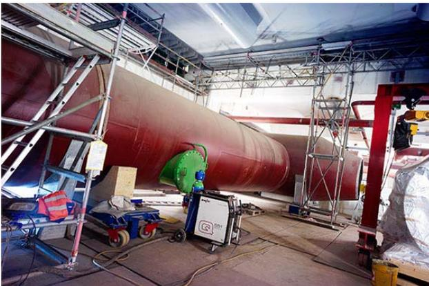
**Abb 2.:** Kühlwasser-Rohrleitungen mit Durchmessern bis zu 3.400 Millimetern – Segment für Segment passgenau verschweißt – erstmals mit vom TÜV Hessen zertifiziertem MAG-Verfahren
