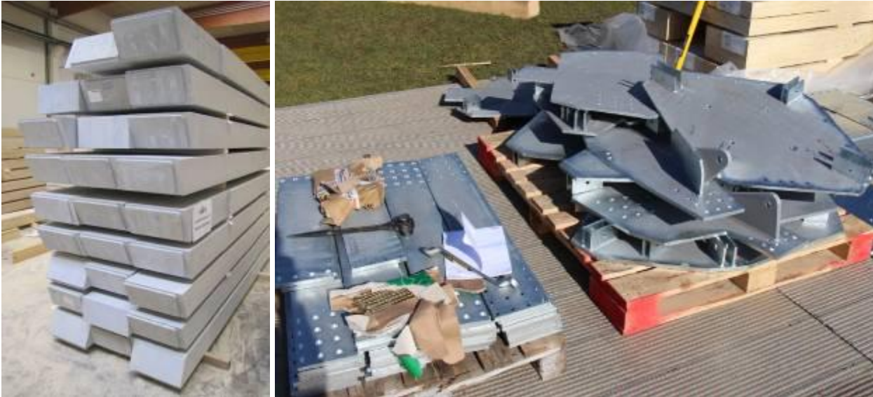
Montagefertig abgebunden und in hellem grau (Adler Lignovit) lasiert verlassen die Brett-schichtholz-Bauteile das Werk im Niederösterreichischen Ober-Grafendorf. 30 t Stahlteile, 20.000 ABC Spax und 2.000 Stahlbolzen Ø 20 x 440 mm bringen die Struktur zusammen.
