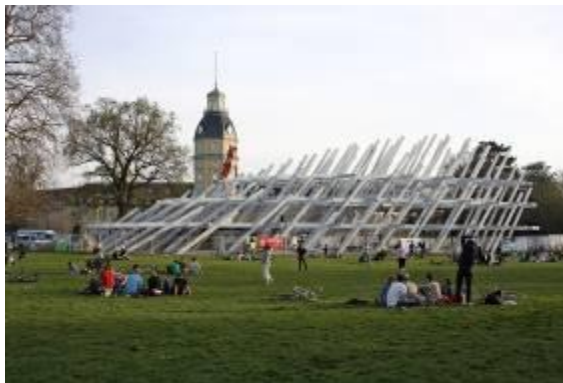
Während des Aufbaus
