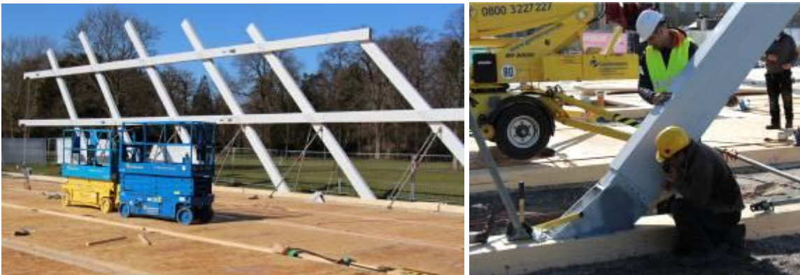
Für den Holzbauer befremdlich: durch die temporäre Nutzung des Bauwerks – nach 13 Festivalwochen wird die Struktur den Schlossgarten wieder verlassen – konnte der konstruktive Holzschutz vernachlässigt werden. Das Leistungspaket des Generalunternehmers beinhaltete die komplexe Tragwerksplanung, 3 D-Konstruktion (Ausführungsplanung, Werkstattplanung), Produktion, Lieferung und Montage samt Zusatzarbeiten wie den Bau von Geländern, Treppen, Wänden und Teilen der Inneneinrichtung.
