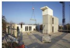
Wand für Wand werden die Geschosse aufgebaut – wie bei den Ein- und Zweifamilienhäusern des Fertighausherstellers auch.
