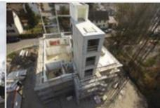
Gut zu erkennen: der Treppenschacht aus Beton und das darum entstehende Mehrfamilienhaus in Fertigbauweise und aus Holz.
