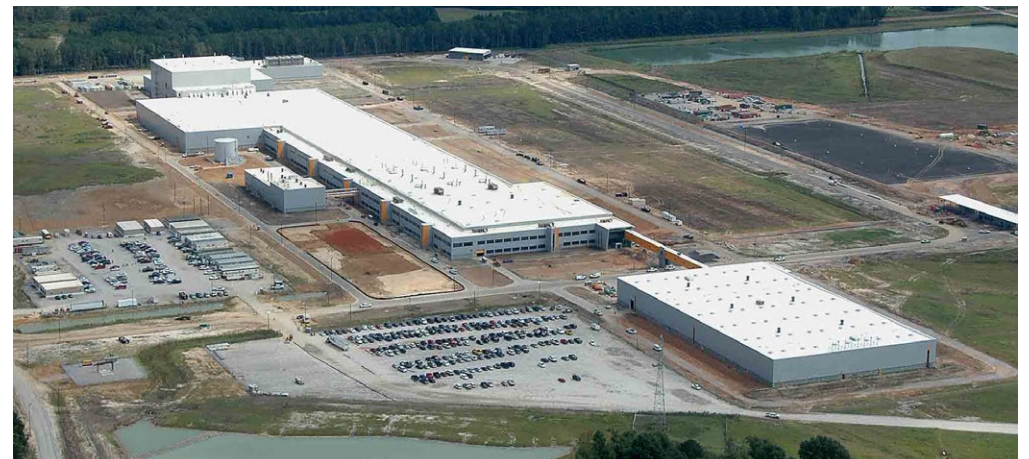
Vogelperspektive auf das neue Reifenwerk in Sumter, South Carolina
